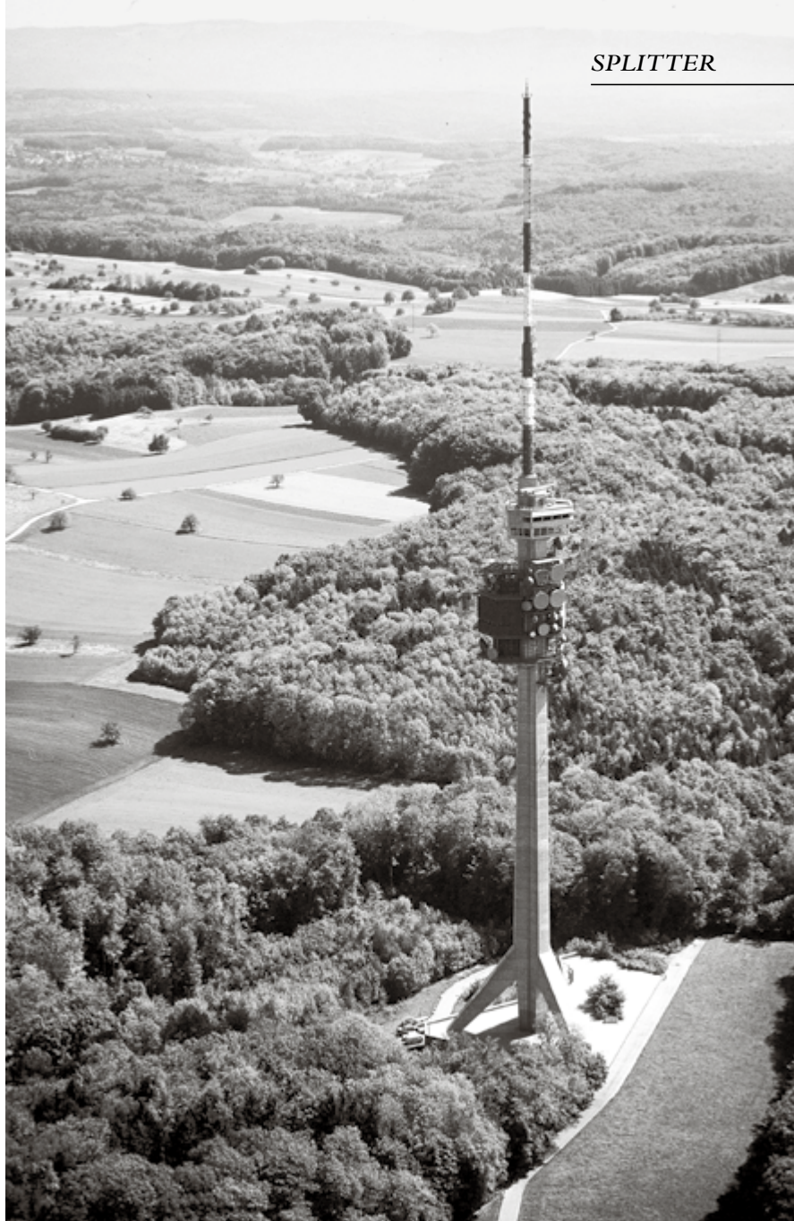
Der Chrischona-Fernsehturm wurde 1984 in Betrieb genommen.
